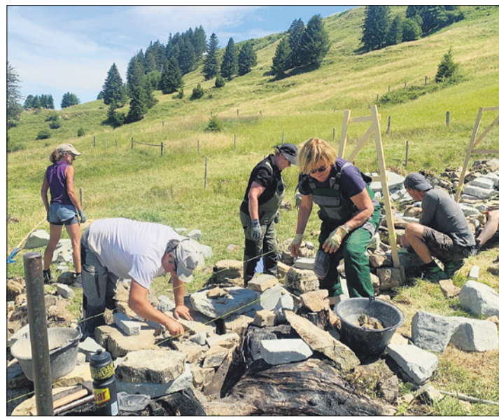
Freiwillige und Zivildienstleistende beim Trockenmauerbau im Appenzeller Bezirk Schwende-Rüte.
